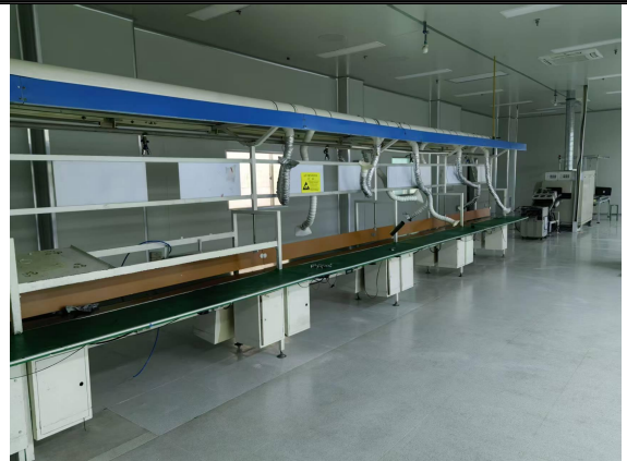
焊接废气集气罩及收集管道
