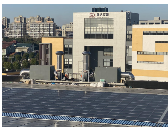
两套活性炭吸附装置和排气筒
